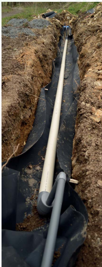
Pose du drain et du Gravier 5-15
