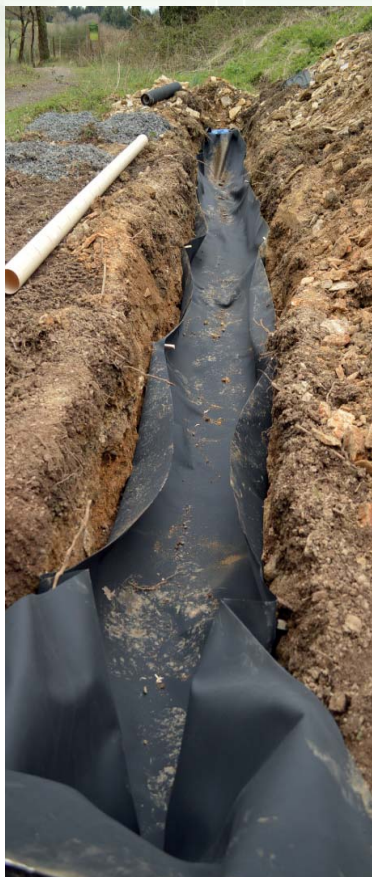
Fond de tranchée de 10 m, pose du liner
