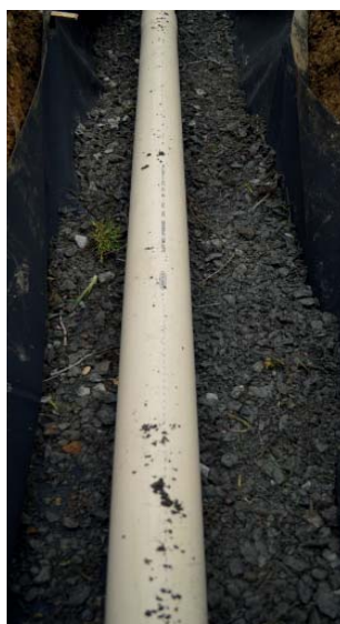
Gravier 5-15 en fond de tranchée
