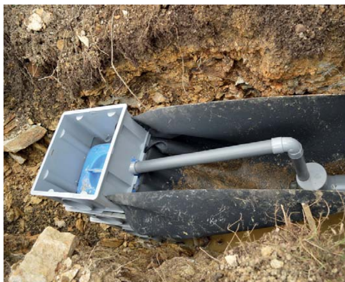
Réalisation du trop plein Attention particulière sur les niveaux du coil de cygne
