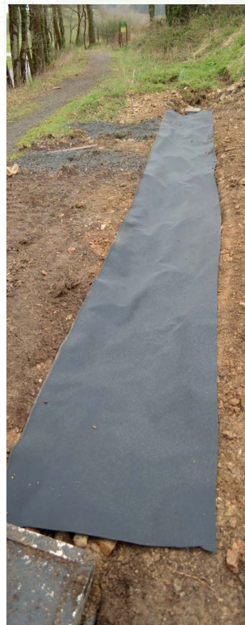
Fin de remblais, 2ème liner qui empêche l'eau de pluie de s'infiltrer pour remplir la tranchée
